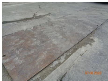
ภาพที่ 2.2-41 การปูพื้นด้วยแผ่นเหล็กบริเวณ ที่ไม่มีการปฏิบัติงาน
