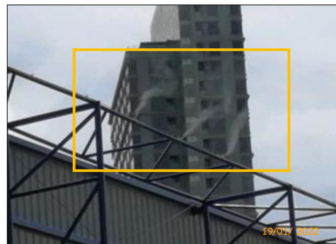
ภาพที่ 2.2-14 ม่านลอนงน้ำบริเวณรั้ว Metal Sheet
