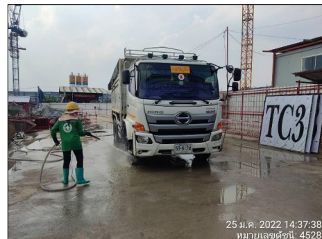
ภาพที่ 2.2-9 พื้นที่ล้างล้อรถบรรทุก
