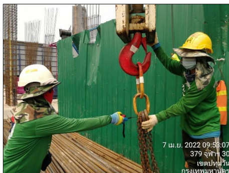
ภาพที่ 2.2-40 การตรวจสอบสภาพระบบเบรก Limit Switch สลิง เชือก อุปกรณ์การยก
