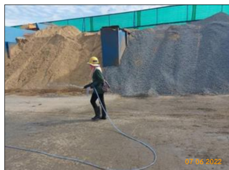
ภาพที่ 2.2-5 การฉีดพรมน้ำบริเวณพื้นที่ เก็บกองวัสดุ
